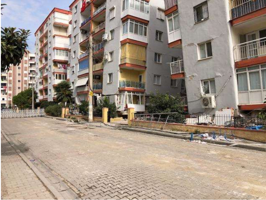
Şekil 5a. Kat göçmesi görülen bazı binalar
