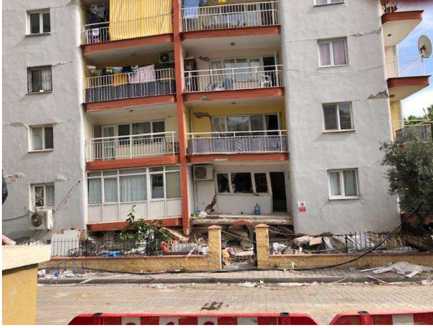
Şekil 5b. Kat göçmesi görülen bazı binalar
