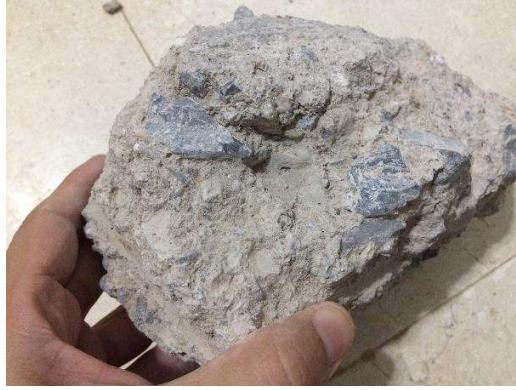
Şekil 6. Betondaki uygunsuz agrega gradasyonu ve homojen olmayan agrega dağılımı
